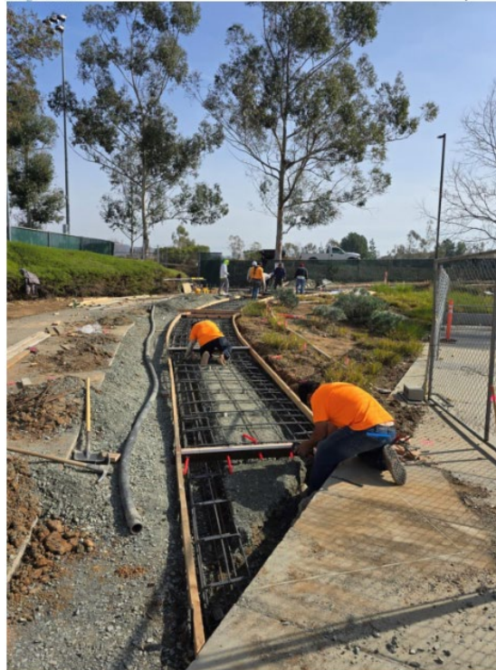
Setting Rebar for Fridav Concrete Pour
