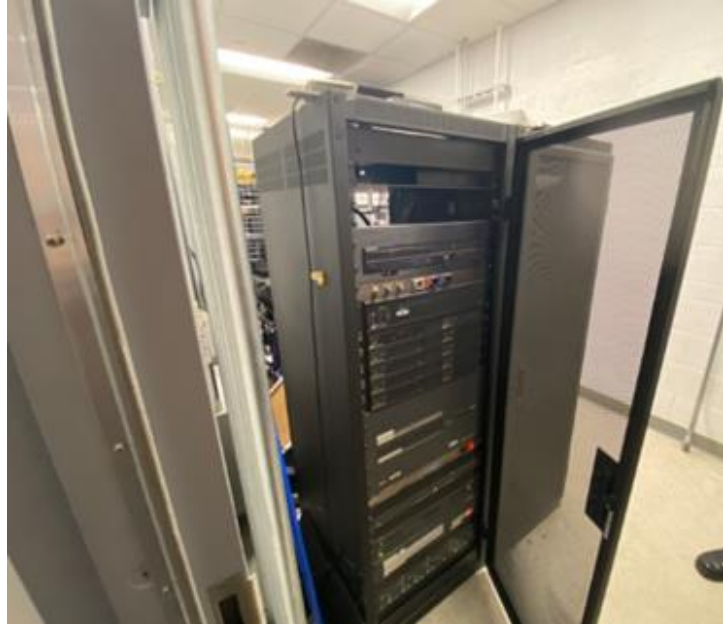
All AV components (except AV Rack) in AV room 119 to be removed.
